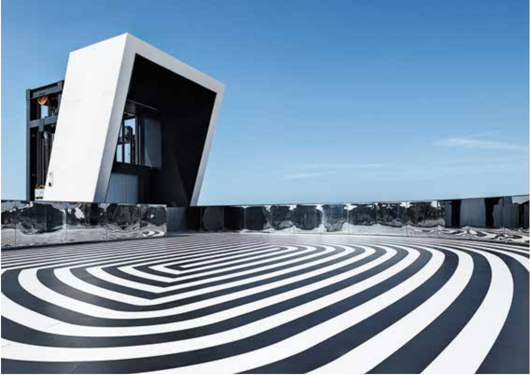
In questa pagina. Sopra da sinistra: la terrazza della torre della Fondazione Prada a Milano, progetto di OMA, con a pavimento una decorazione optical in bianco e nero realizzata con la collezione Absolute di Lea Ceramiche e uno degli spazi interni all'edificio. In basso: The Library, spazio privato a Hong Kong di un collezionista progettato dallo studio A Work of Substance, con la serie L2 di Lea Ceramiche su parte del pavimento dell'area che ospita le automobili e i servizi. Pagina a fronte: il Museo Archeologico Nazionale di Reggio Calabria, progetto di ABDR Architetti Associati, con pavimenti della collezione Over di Cotto d'Este
